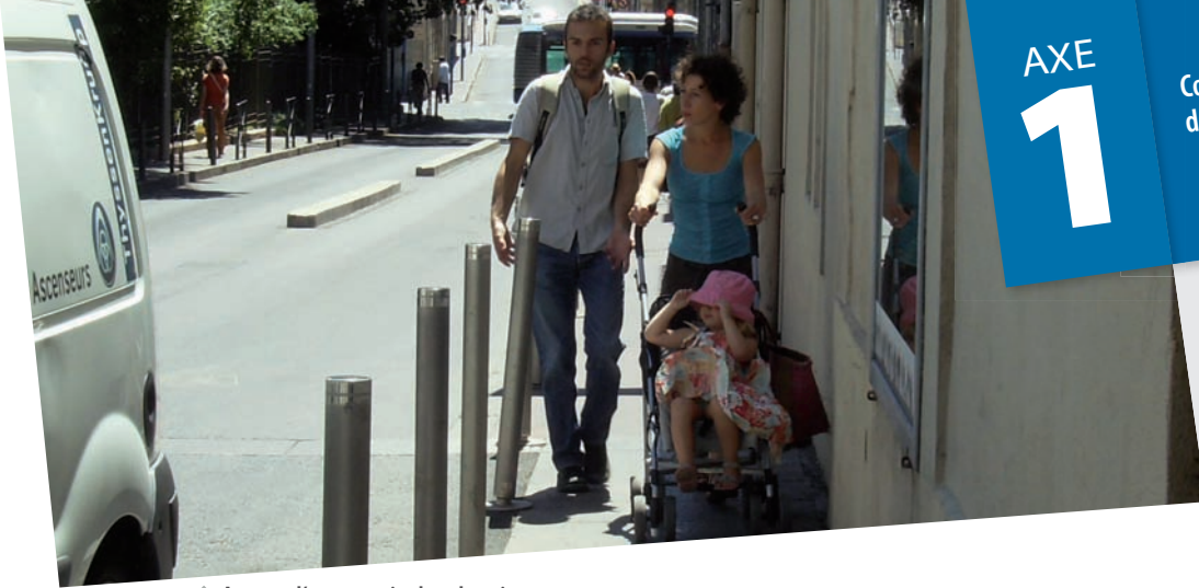
↑ Assurer l'ergonomie des cheminements Dans l'exemple ci-dessus, la faible largeur du trottoir et l'encombrement supplémentaire généré par les potelets rend le déplacement de deux personnes côte à côte inconfortable.
