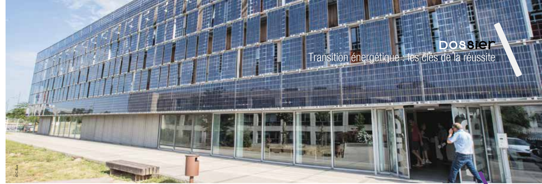
La façade du MIBI produit 76 MWh/an d'électricité verte, grâce à ses panneaux photovoltaïques. Soit une économie de 16 tonnes de CO 2 /an.
