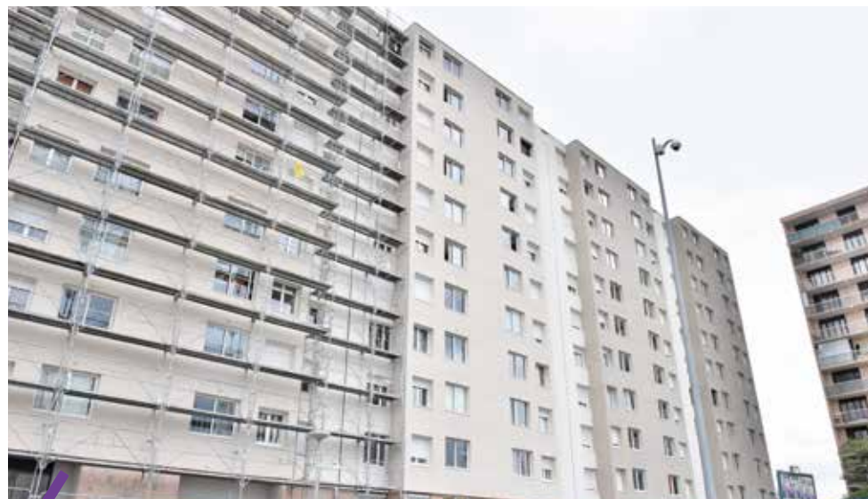
La copropriété les Flamants roses dans le quartier des Hauts de Massane (Montpellier) a bénéficié d'une rénovation thermique de sa façade.
