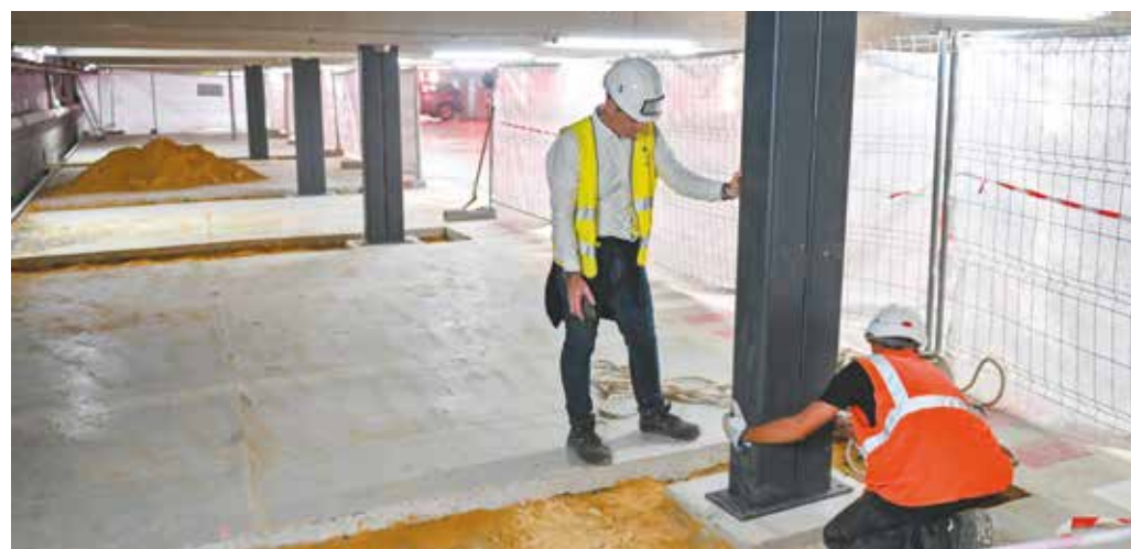
Un chantier spectaculaire : les poteaux de 8 m de haut ont été installés avec une grue télescopique et reposent sur les fondations au niveau - 4 du parking.
