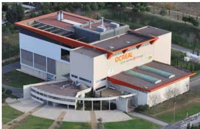
Unité de valorisation énergétique OCREAL
