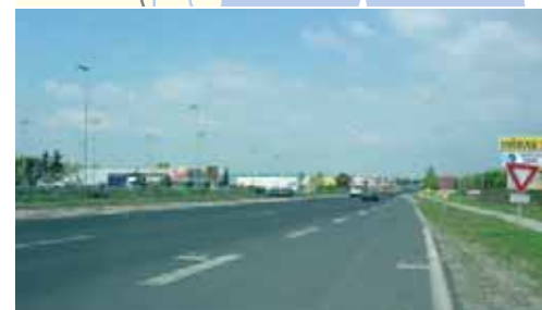
état actuel de la RD21
