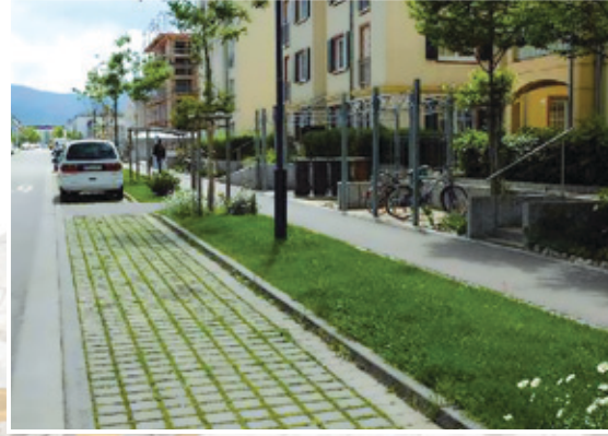
Aire de stationnement autorisant l'infiltration des eaux pluviales
