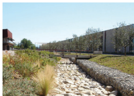
Traitement du sol permettant l'infiltration et l'écoulement naturel des eaux de surface
