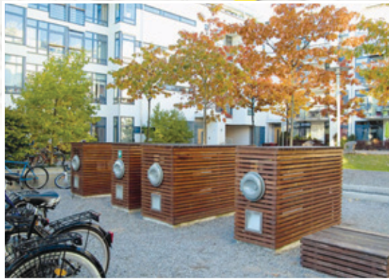
Conteneurs de tri sélectif enterrés situés en pied d'immeuble
