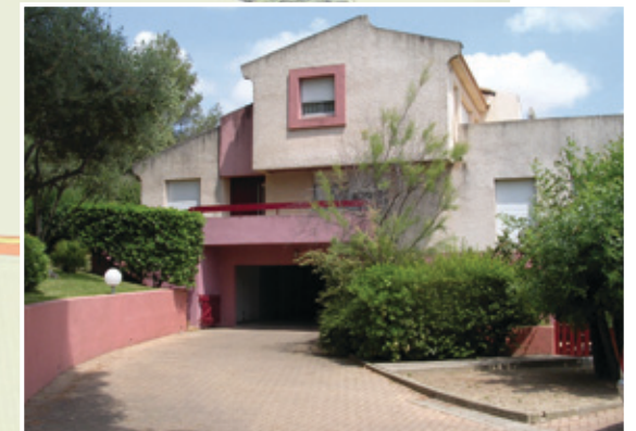
Stationnement intégré Opération d'habitat intermédiaire
