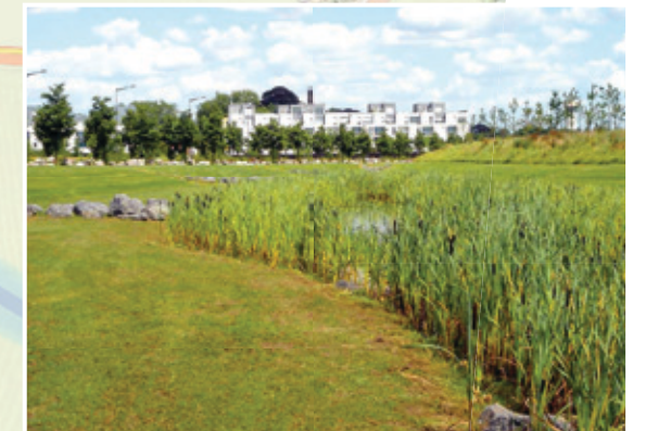
Bassin de rétention paysager
