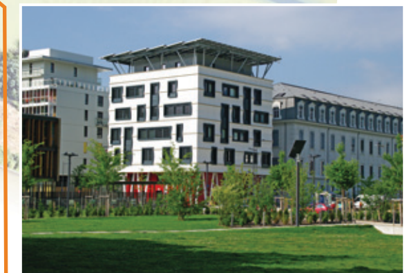
Panneaux photovoltaïques intégrés à la toiture
