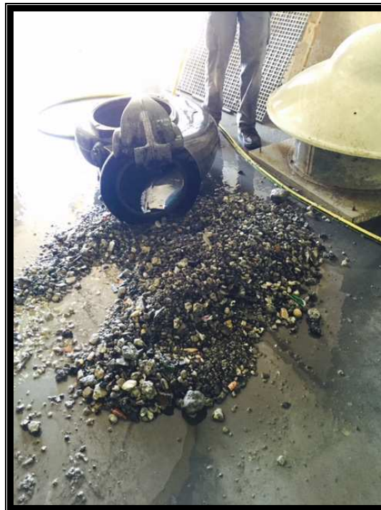
Débouchage des pompes de vidange du BO des Aiguerelles.
