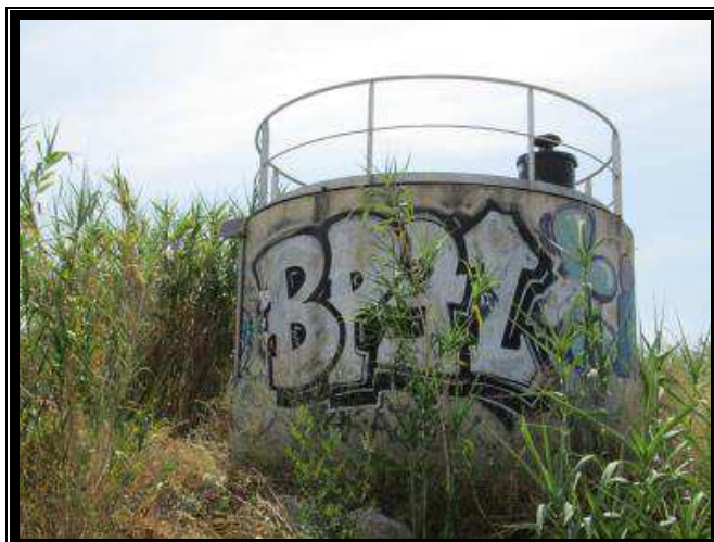
N°5 Cheminée Ariane à Lattes
