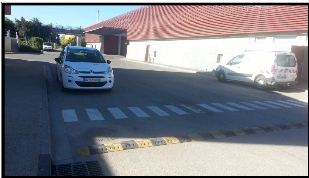
Vue d'un dos d'âne et du passage piéton.
