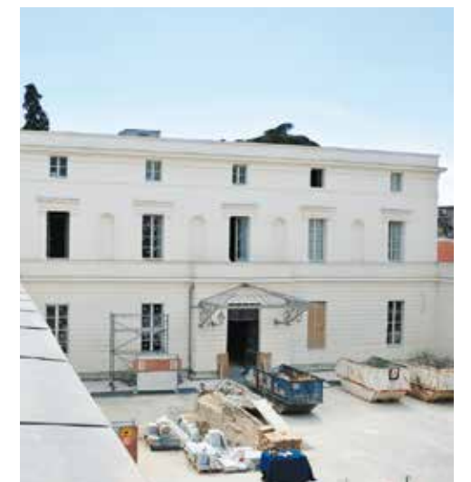
L'arrière cour du bâtiment, en cours de rénovation.
