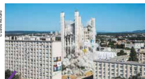
Le renouvellement urbain, comme ici l'explosion de la tour H au Petit Bard, où des logements ont été reconstruits ces dernières années, est un des piliers des contrats de ville.
