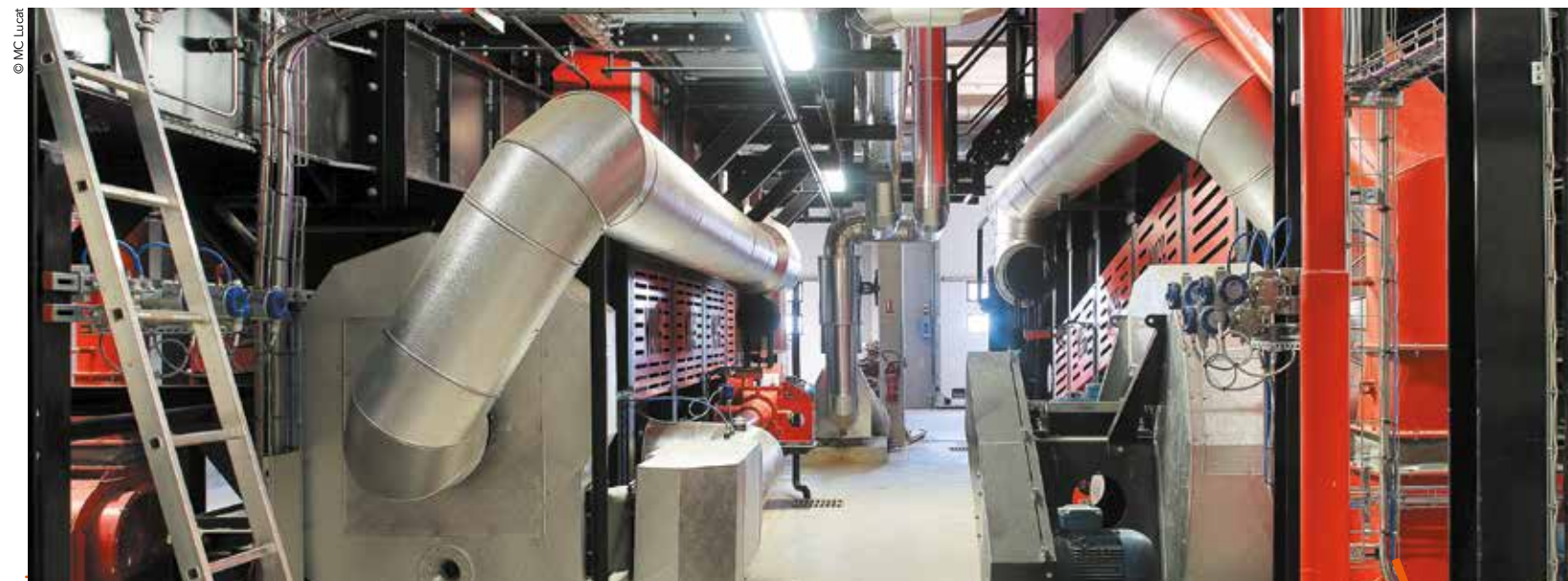
La centrale trigénération de Port Marianne alimente en énergies les quartiers alentours à partir de bois.
