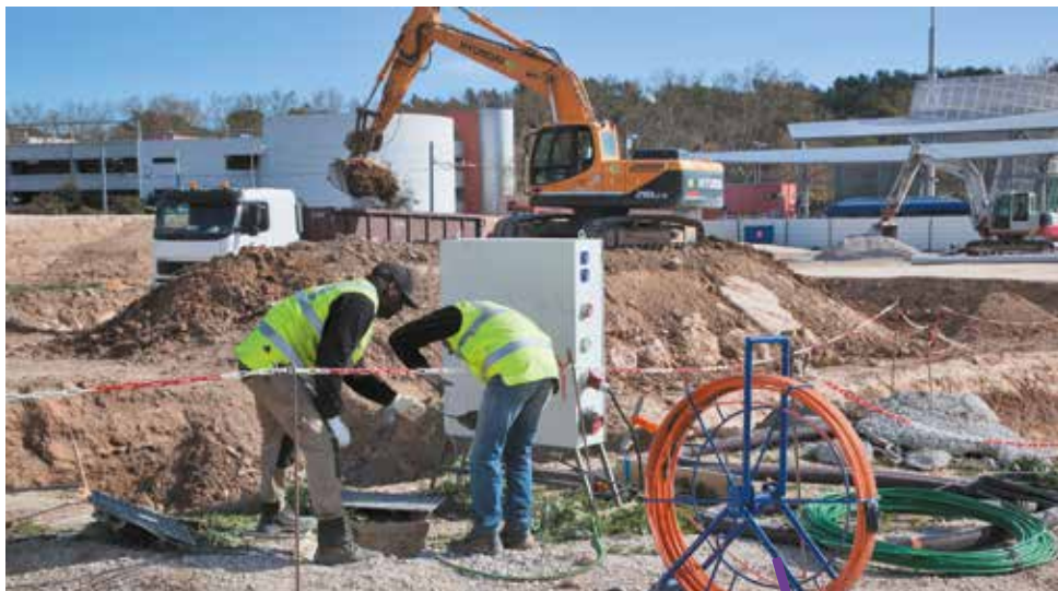
La fibre optique est placée dans des gaines sous les voiries, avec d'autres réseaux, sur un chantier au nord de Montpellier.
