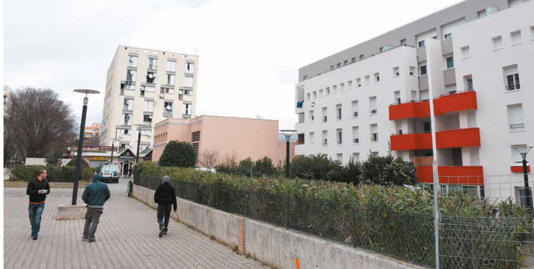
Le Grand Mail à la Mosson est au cœur du chantier de rénovation urbaine à Montpellier.
