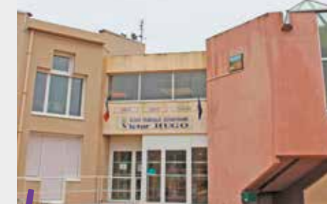
Clapiers a équipé l'école Victor Hugo d'une chaufferie à bois, source d'économies.
