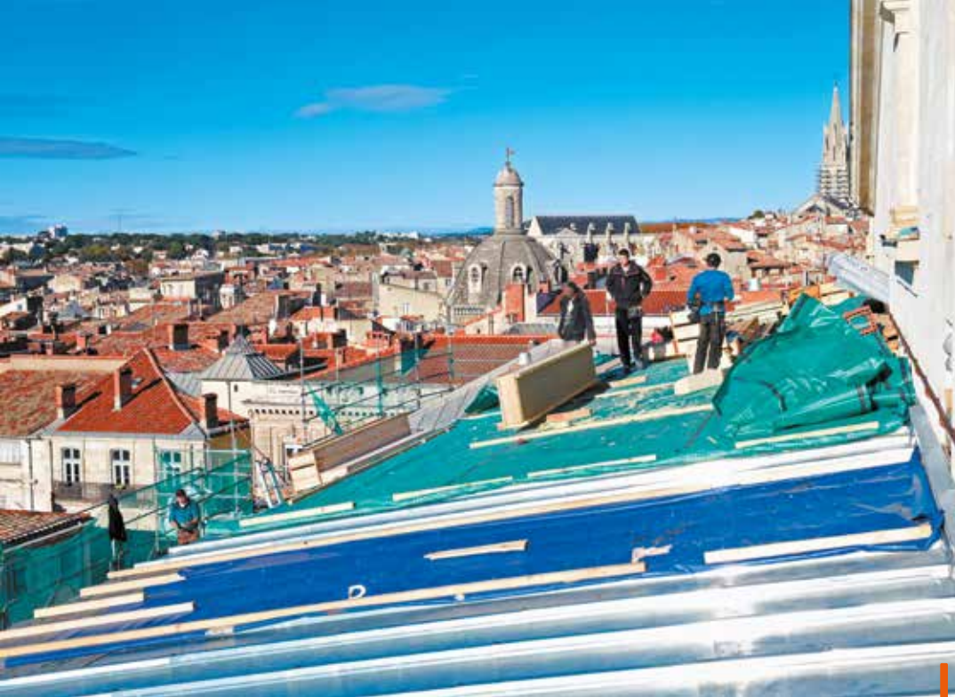
Un chantier vertigineux sur le toit en zinc de l'opéra Comédie.
