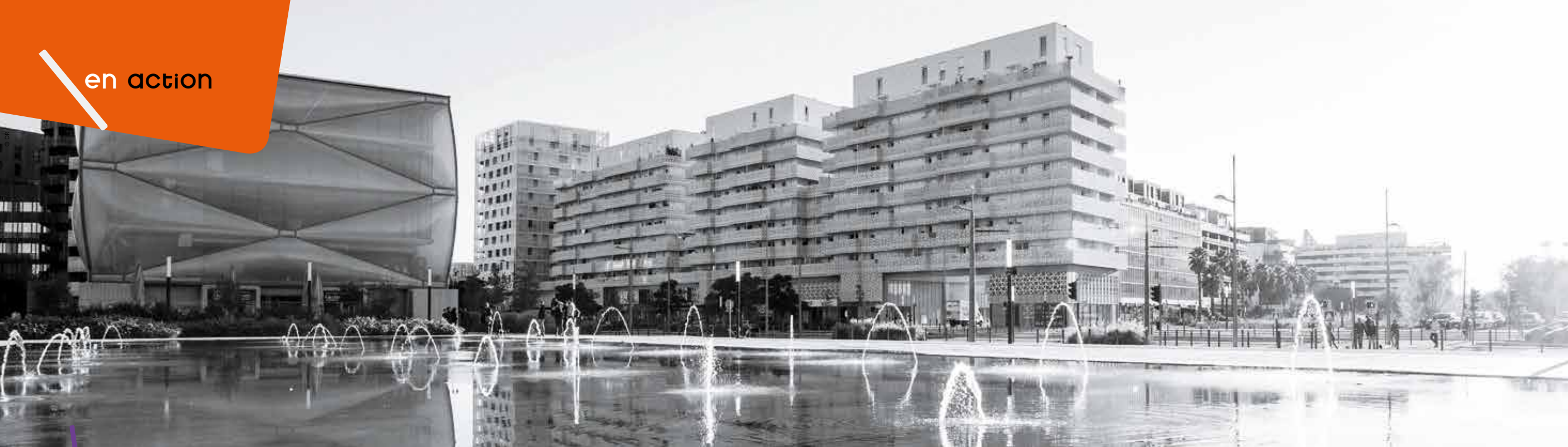
La Mantilla, dans le secteur de l'Écocité à Montpellier, un bâtiment intelligent équipé de milliers de capteurs connectés.
