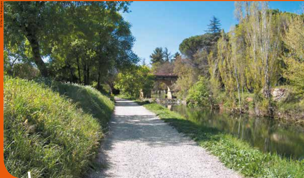
La restauration du Coulazou qui traverse la commune de Fabrégues est en cours.
