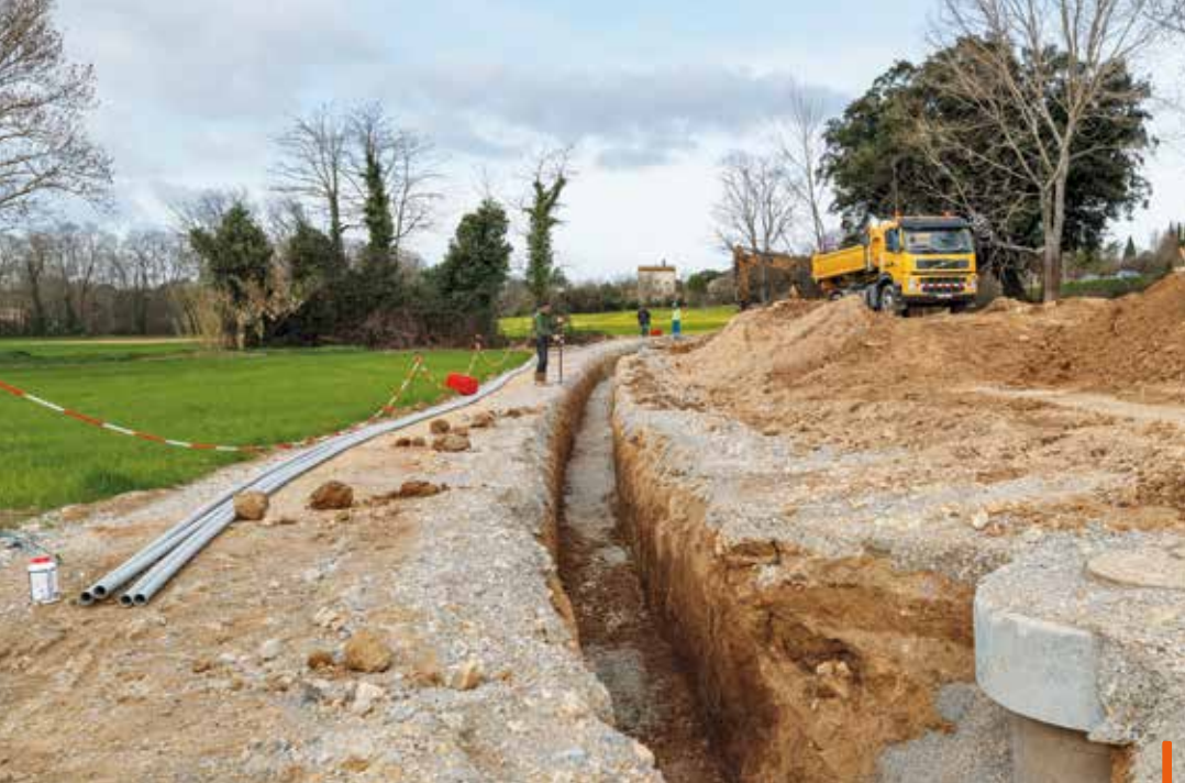
En prévision du doublement de la RD65 à Clapiers, sur cette portion, les réseaux d'assainissement sont placés sous la future piste cyclable.
