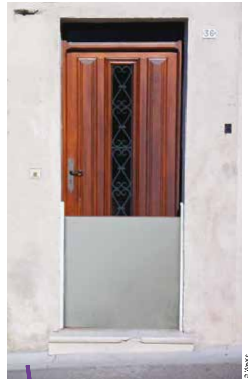
La pose d'un batardeau, une barrière anti inondation amovible, permet d'occulter les portes ou les fenêtres jusqu'à 1 mètre de hauteur.
