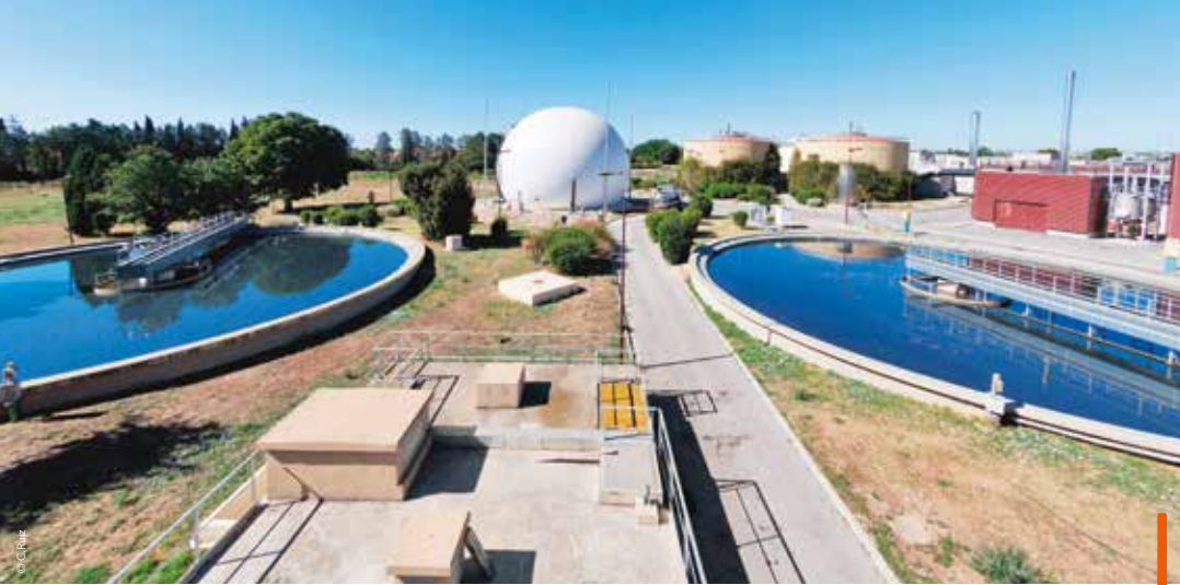
Les travaux de modernisation de la station, mise en service en 2005 à partir d'ouvrages datant de 1962, sont financés entièrement par Montpellier Méditerranée Métropole.
