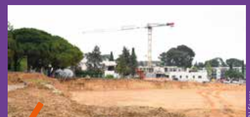
Le chantier de l'Atrium Learning Center, nouveau concept de bibliothèque inter-universitaire.
