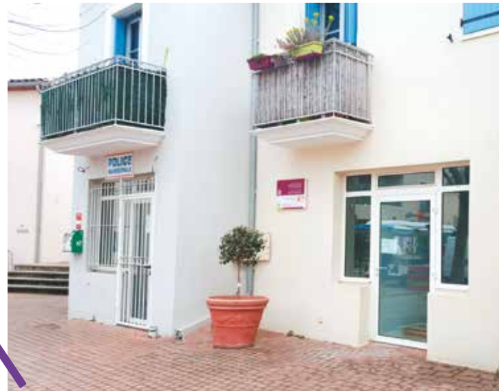
Une salle communale aménagée pour accueillir un nouveau médecin.
