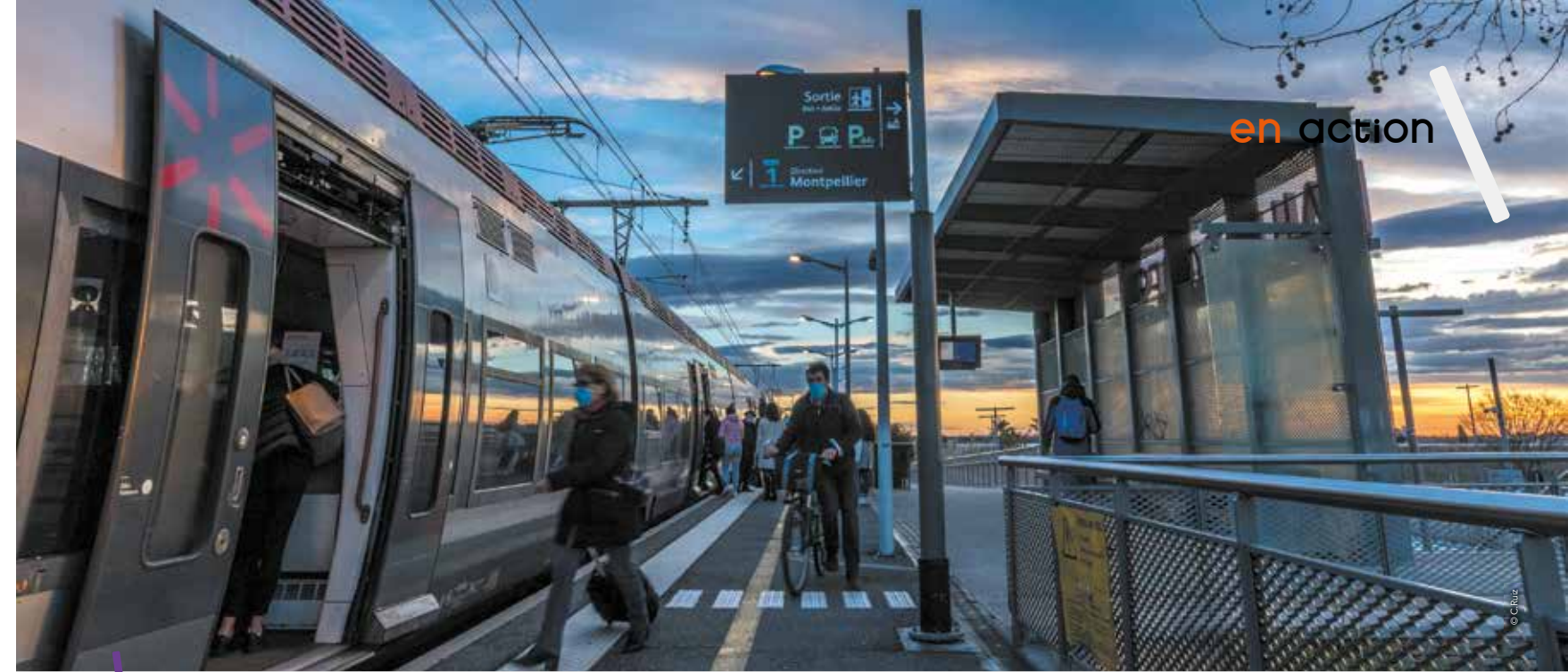
Fonctionnel depuis 2017, le PEM de Baillargues réalisé par la Région Occitanie permet de privilégier les modes de transport plus écologiques autour du ferroviaire.
