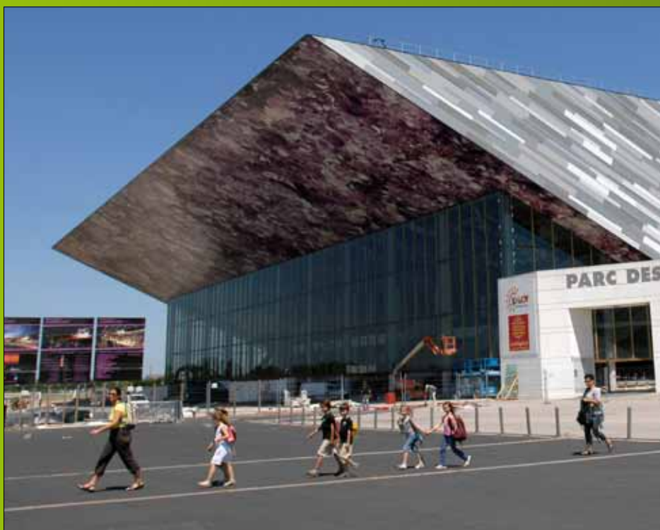
Le chantier colossal de la salle nouvelle génération de Montpellier Agglomération et de la Région Languedoc-Roussillon entre dans sa dernière ligne droite au Parc des Expositions à Pérols.
