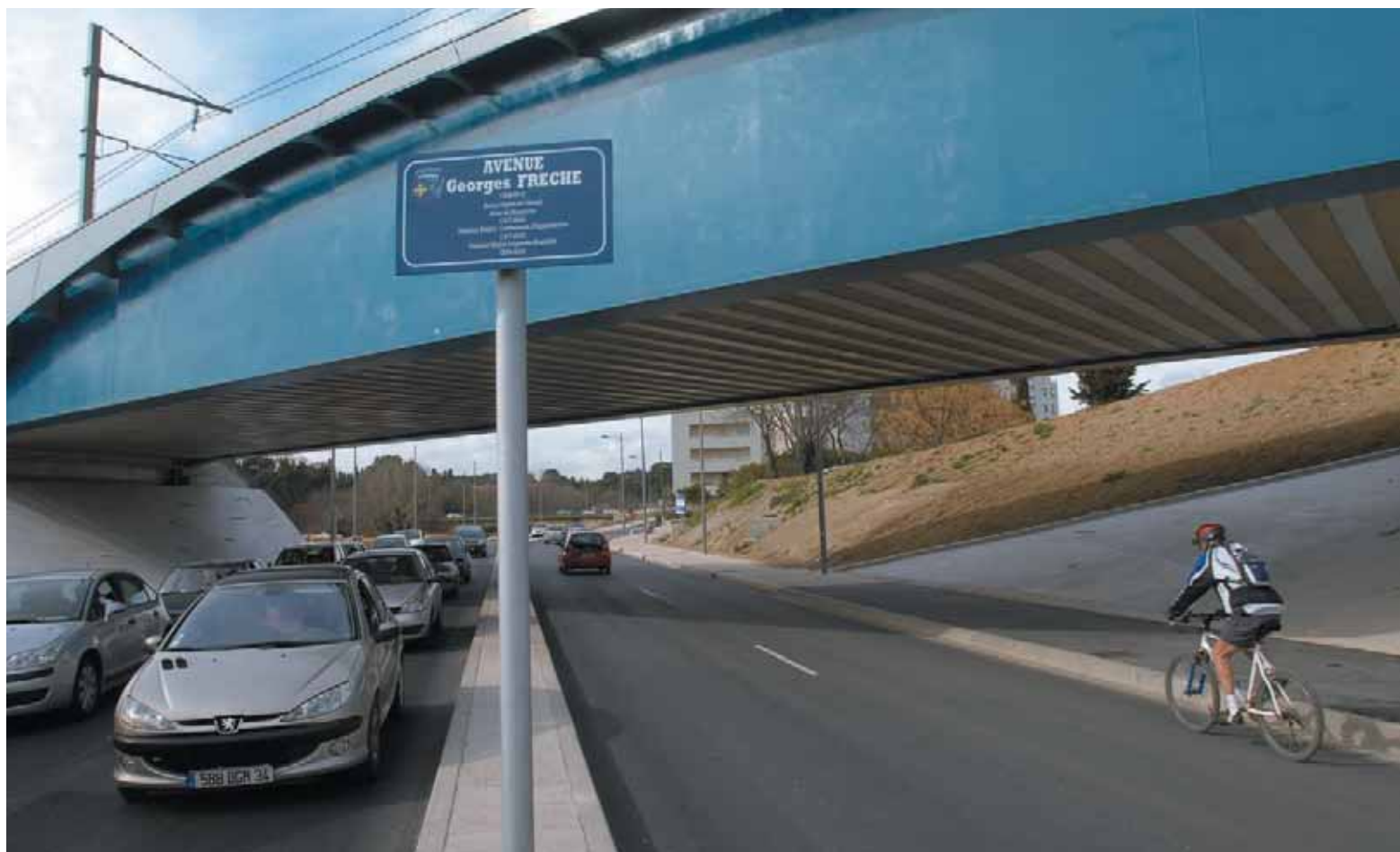
Le passage de l'avenue Georges Frêche sous le nouveau pont de la voie ferrée, ouvert depuis février dernier, a une emprise de 17 mètres de large, 3 fois plus importante que l'ancien passage.
