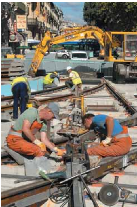
Grâce à la clause sociale, des personnes en insertion sont employées sur le chantier de la ligne 3.
