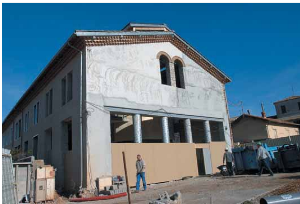
La façade de l'ancien chai, rue Gaston Bazille à Pérols.
