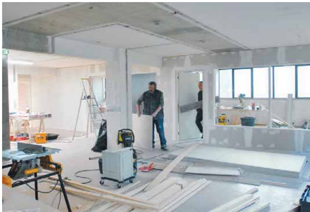
Les travaux de construction du décor à l'Hôtel de l'Agglomération de Montpellier.
