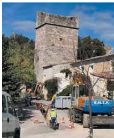
Les travaux de raccordement à Montaud.
