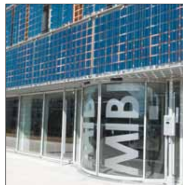
Le Mibi, un des nombreux équipements de Montpellier Agglomération qui produit de l'électricité verte.
