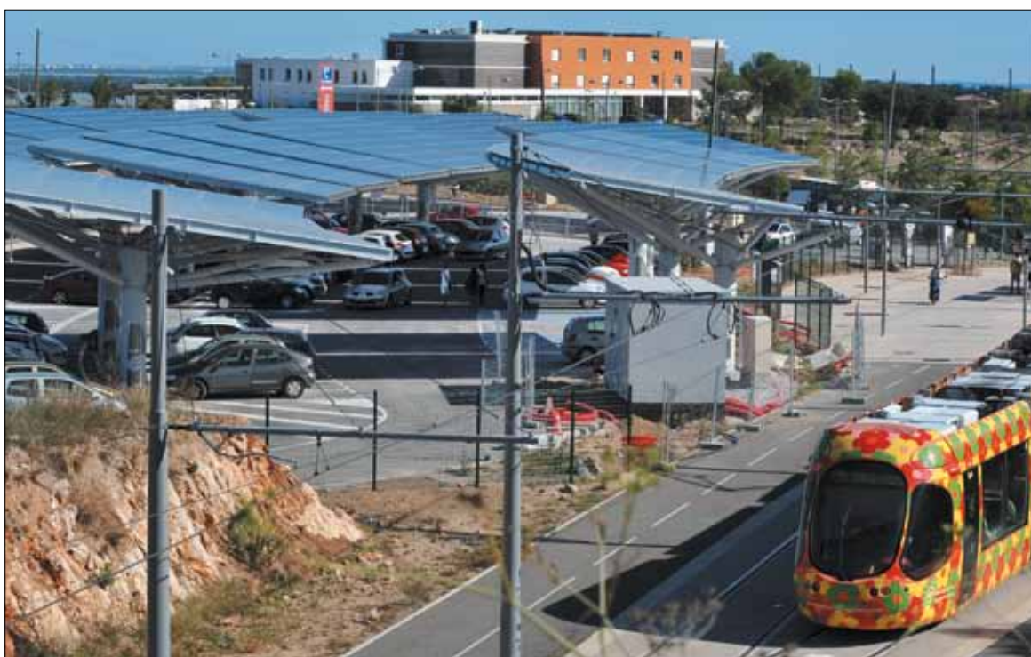
Au total, 7364 m 2 de panneaux photovoltaïques ont été posés sur les parkings de Castelnaud-le-Lez (photo) et Saint Jean de Védas.
