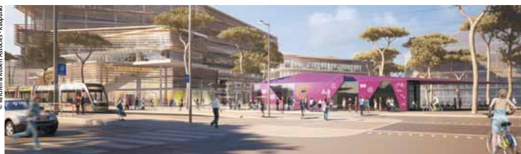
La future station Pailletrice au cœur de la ZAC Parc de l'aéroport à Pérols.
