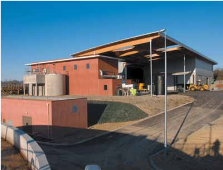
Dans cette nouvelle station de Montpellier Agglomération, les eaux filtrées sont ensuite traitées par rayons ultra-violet qui détruisent les microbes, virus et bactéries.
