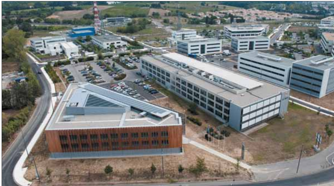
De Montpellier à Castelnau-le-Lez, le vaste parc Eureka accueille notamment Cap Omega, le MIBI et un tout nouveau pôle de services.
