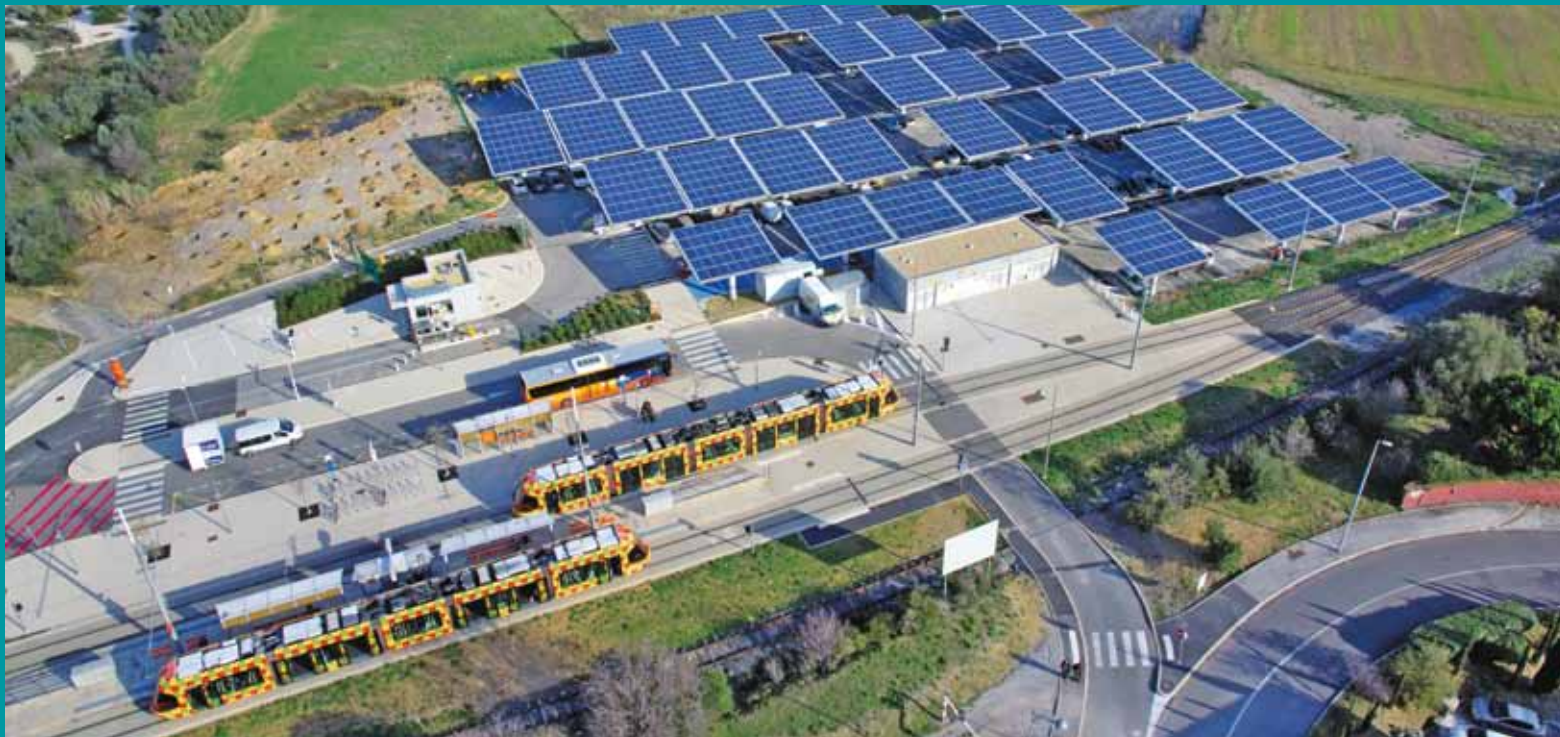
Le parking d'échanges tramway « Saint Jean le Sec » à Saint Jean de Védas produit de l'électricité verte.
