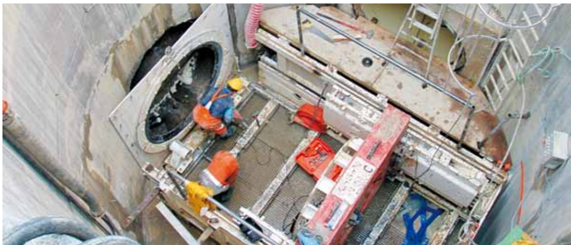
Déjà en 2009 et 2010, trois communes hors Agglomération, Assas, Teyran et Saint-Aunès ont été raccordées à Maera.
