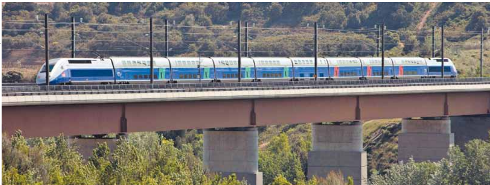
Dans cinq ans, les trains à grande vitesse et les trains de marchandises circuleront sur cette nouvelle ligne Nîmes-Montpellier.
