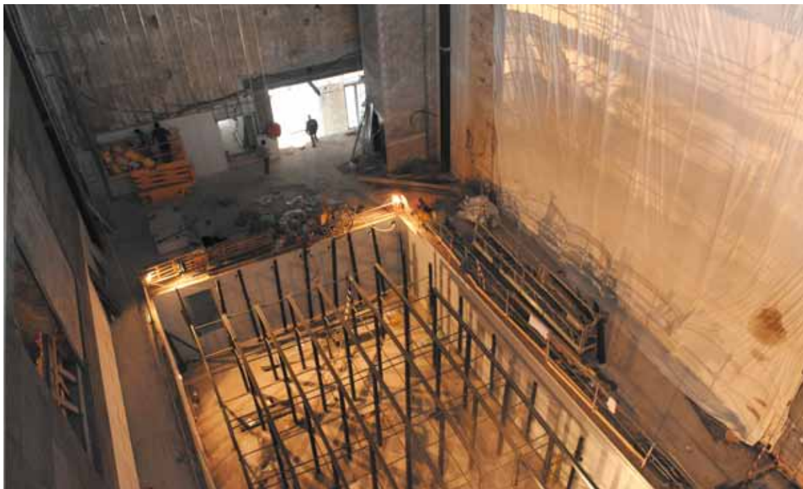
Avancée des travaux sur la cage de scène : le gros œuvre est achevé.
