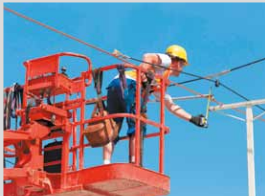
Les lignes aériennes de contact se détendent à cause de la chaleur. Les agents TaM installent des contrepoids.
