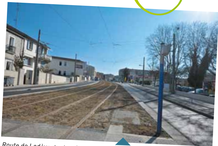
Route de Lodève, tout au long de la voie de la ligne 3, le quartier Celle-Neuve est en pleine mutation.
