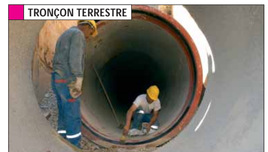
Des tuyaux de fonte de 6 m de longueur et 1,60 m de diamètre forment les 4,8 km du tronçon terrestre de l'émissaire.
