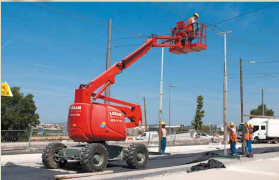
Une équipe Ineo Scle effectue les réglages de la LAC près de la station « Pilory ».
