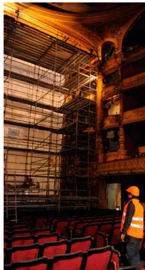
Derniers travaux sur la cage de scène qui a été totalement refaite à neuf.
